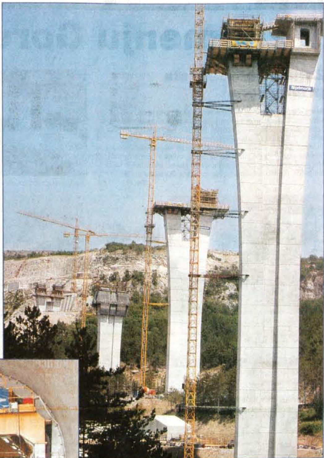
Viadukt Črni Kal spaja Kras in Istro.
