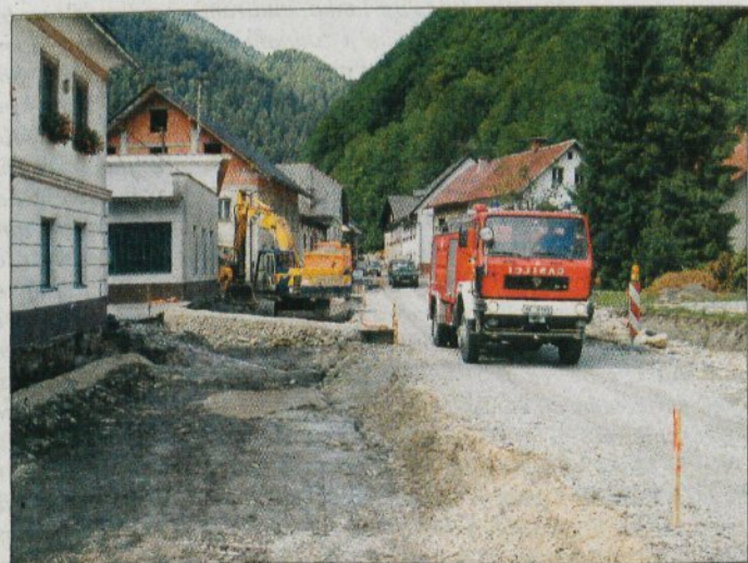
Skozi stari del Železnikov, Na Trnju, poteka najbolj zahtevna rekonstrukcija regionalne ceste.
