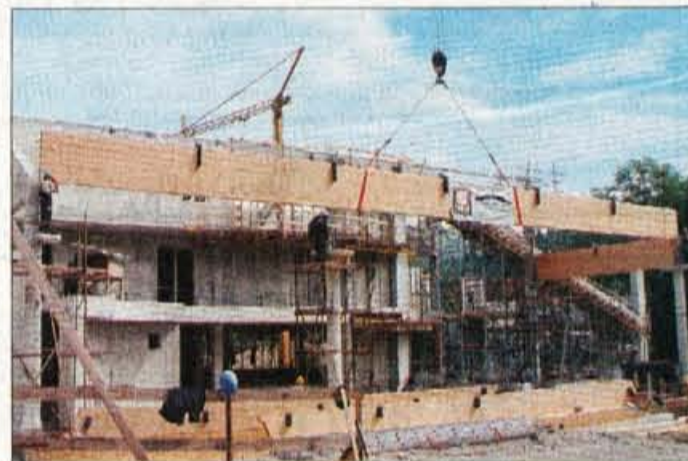
Vgradili so enega najdaljših lesenih lepljenih nosilcev v Sloveniji.
