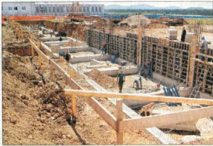
Temelji za brniški hangar.
