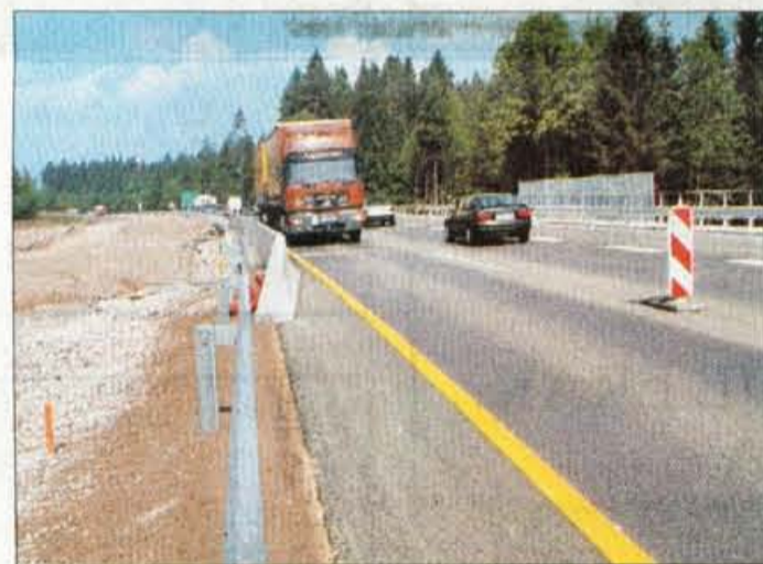
Po skoraj dveh kilometrih levega pasu bodoče avtoceste že poteka promet.
