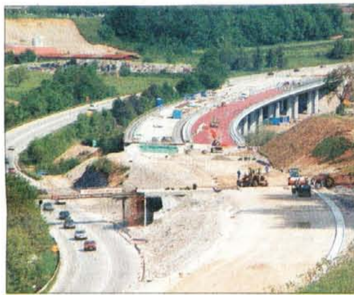
Na viaduktu Tržiška Bistrica izdelujejo hidroizolacijo levega objekta.
