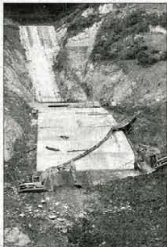
Skakalnica je globoko zarezala v Šmarjetno goro. Rušil je zanesljivo ne bo nihče, trenutno betonira jo doskokišče.
