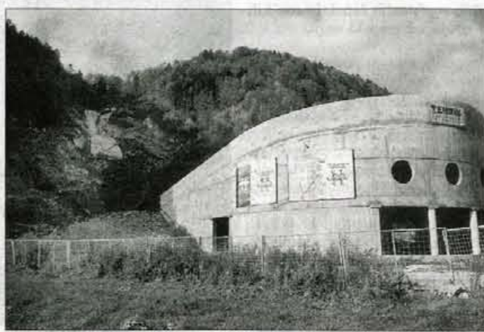
Gradbišče skakalnice je od sosednjega zemljišča ločeno z ograjo.
