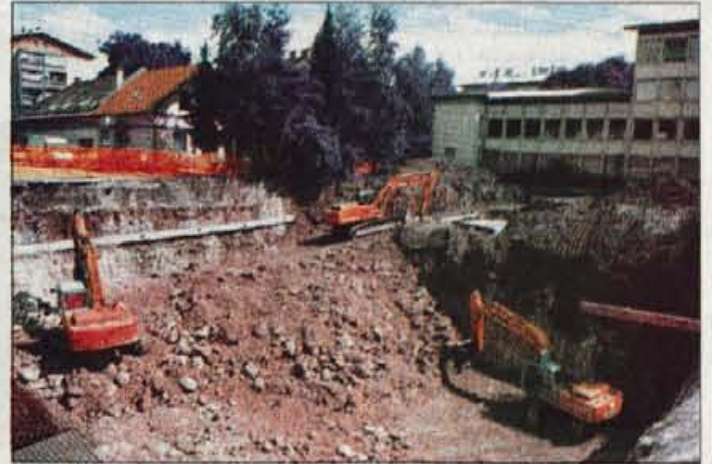
Pred gradnjo drugega dela poslovnega centra morajo porušiti nekdanji dom JLA, dovoljenja še nimajo.
