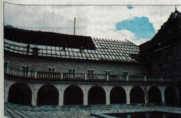
Na grad Brdo se prav zdaj vrača stara kritina, opečnati bobrovec. Vodnjak pred njim je bil obnovljen ob obisku šestnajstih predsednikov.
