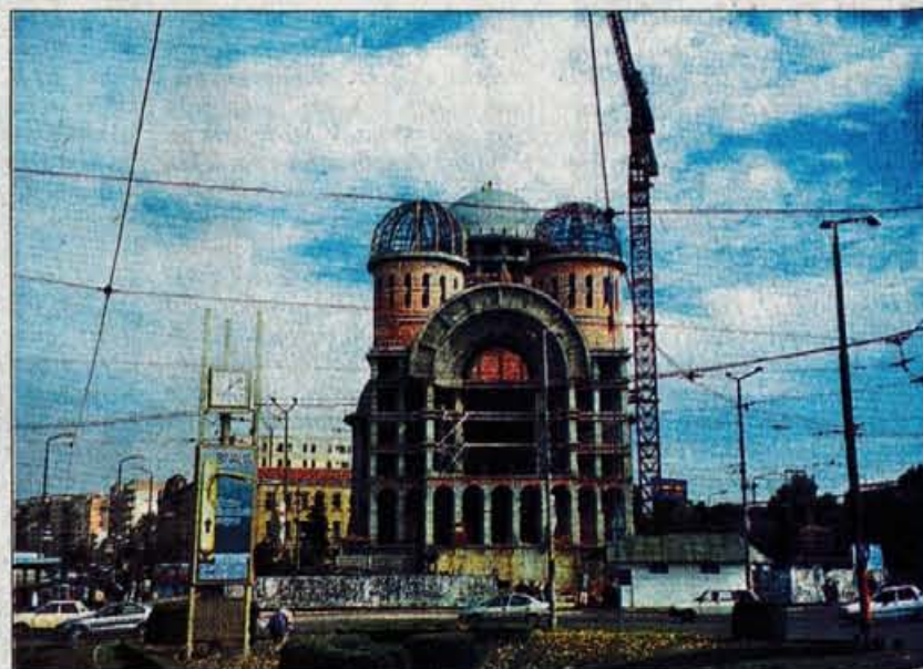
... in gradnja nove pravoslavne cerkve.
