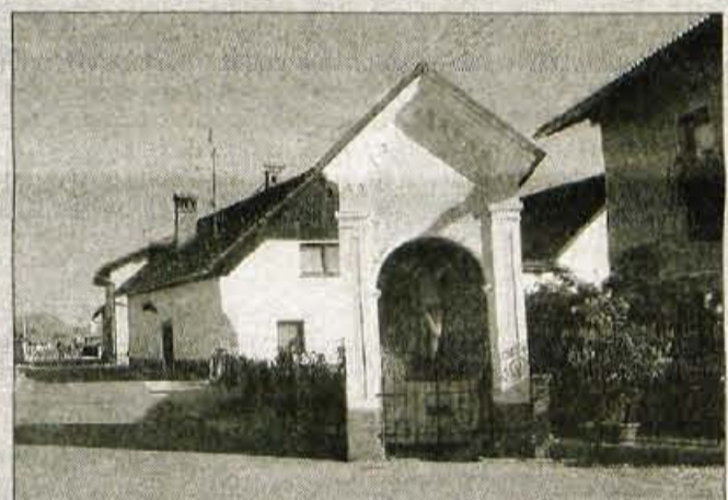
Za obnovo kapelice in znamenj pod pokroviteljstvom občine Mengeš so namenili več kot milijon tolarjev.
