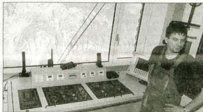
V strojnici: strojnik Matej Krese je povedal, da je upravljanje nove nihanke veliko bolj enostavno, upravlja jo kar voznik v kabini, čeprav bi jo lahko tudi iz strojnice. Takšna je menda praksa proizvajalca Pomo. V strojnici tako skrbijo zgolj za nadzor.
