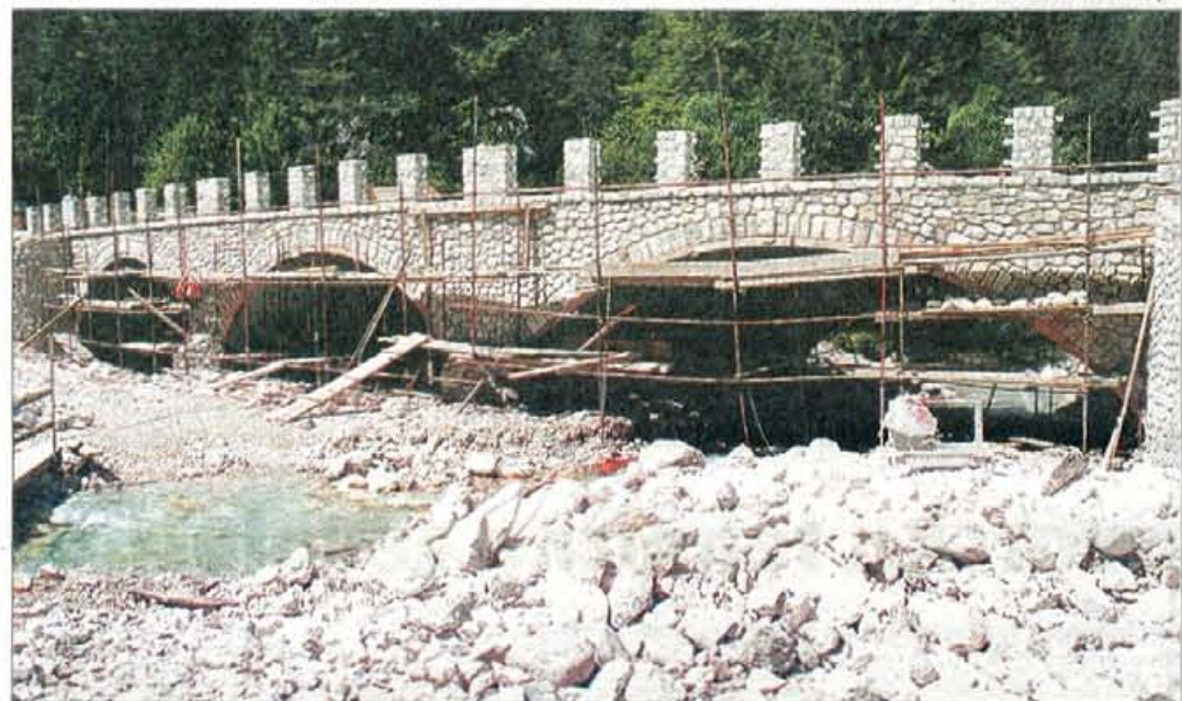
Na cesti v Eriki gradijo kamnit most, otvoritev bo začetek septembra.
