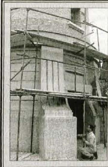
Kranj, 22. maja - Pred dnevi se je okoli vodovodnega stolpa v Kranju pojavil zidarski oder, saj Javno podjetje Komunala Kranj, enota Vodovod obnavlja spodnji del vodovodnega stolpa v Kranju. Kot nam je pojasnil Roman Šter nam navdajo spodnji temelji, ker se je v njem pokazalo nekaj razpok, zato je potreben sanacija. "Obenem bomo spodnji del stolpa tudi prepletkali, kar sodi v sklop urejanja okolice vodovodnega stolpa. V tem okviru bo v kratkem sledila še zatrvitev okolice," je še dejal Roman Šter iz Komunale Kranj, enote Vodovod. • S. S., G. K.
