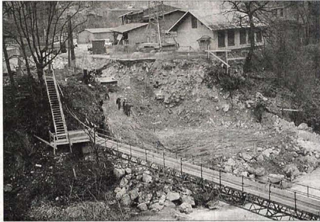
Družba Primorje iz Ajdovščine je začela v Podmežakli graditi nov most čez Savo, ki bo zgrajen do konca letošnjega leta. Gradnja mostu bo stala več kot 180 milijonov dolarjev, prispevek iz sredstev PHARE znaša okoli 55 milijonov dolarjev, ostala sredstva pa morata zagotoviti občina in država.
