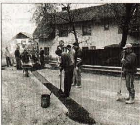
Še zadnja dela na cesti skozi vas Luže, kjer se je sedaj že mogoče voziti.
