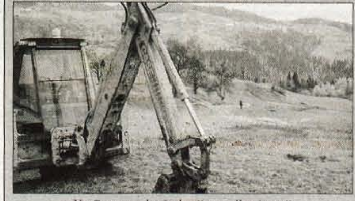
Na Starem vrhu še brnijo gradbeni stroji.
