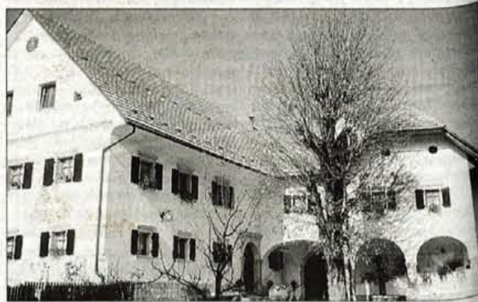
Lepo obnovljena Hartmanova stanovanjska stavba, ki se nadaljuje v hlev, sodi med boljše primere stavbne umetnosti 18. in 19. stoletja na loškem ozemlju.
