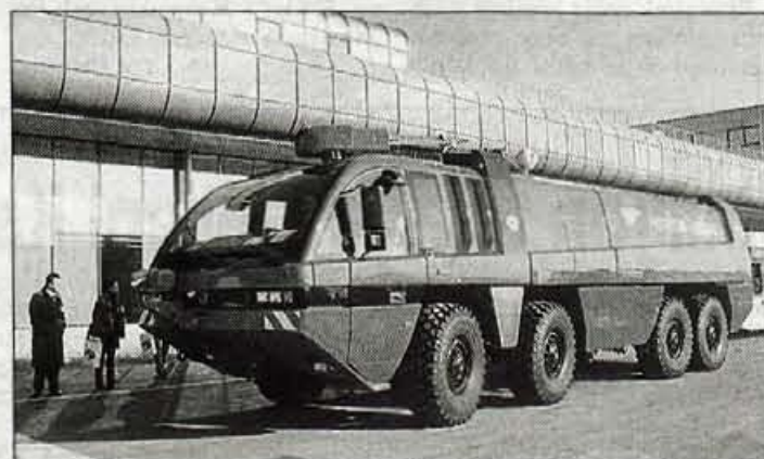
Najsodobnejše gasilsko vozilo Rosenbauer Panther poganja motor s tisoč konjskimi močmi; vozilo je vredno 150 milijonov tolarjev.
