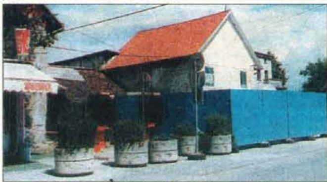
Dovoljena le obnova sedanjega kioska Pinki, čemu služi njegovo bližnje gradbišče?
