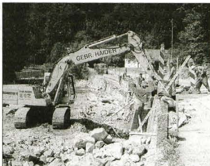
Novi oporni zid ob reki Sori bo končan do konca avgusta, ko bo konec delne cestne zapore.
