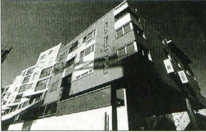
Nov poslovno stanovanjski kompleks je eden najbolj reprezentativnih objektov v Ljubljani, izvajalec gradbenih del Graditelj Kamnik ga je dokončal v 14 mesecih.
