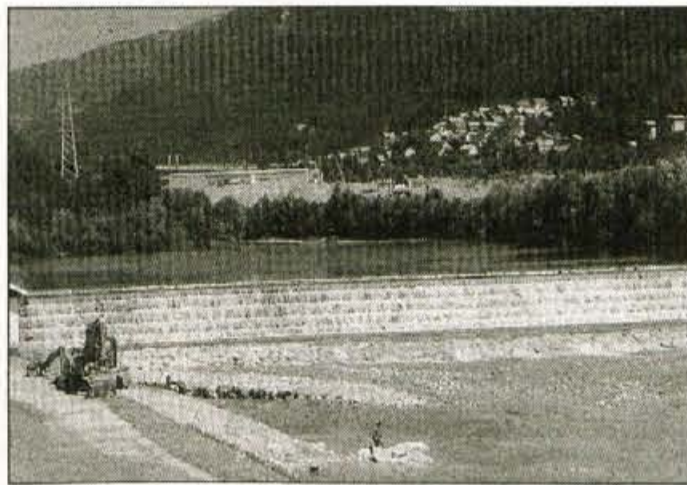
Savske elektrarne so že pred časom temeljito sanirale strugo Save in potoka Javornik na Slovenskem Javorniku. Obnovili so pregrado za prodni zadrževalnik ter očistili savsko obrežje.
