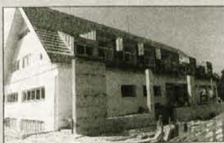
Dela pri gradnji nove stavbe policijske postaje na Trati se končujejo.
