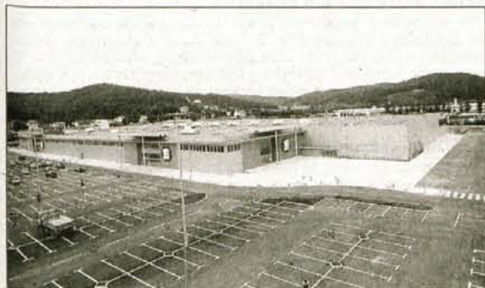
Na Rudniku v Ljubljani (tja je moč priti z južne ljubljanske obvoznice ali na Viču čez železnico pri Viatorju) je francoski E. Leclerc odprl največje slovensko nakupovalno središče.
