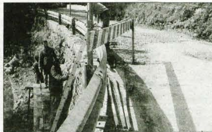
Na ovinku v Dolini popravljajo oporni zid in poškodovano cesto.
