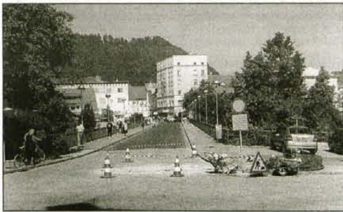
Priprave za montažo potopnih stebričkov. Foto: D. Gazvoda
