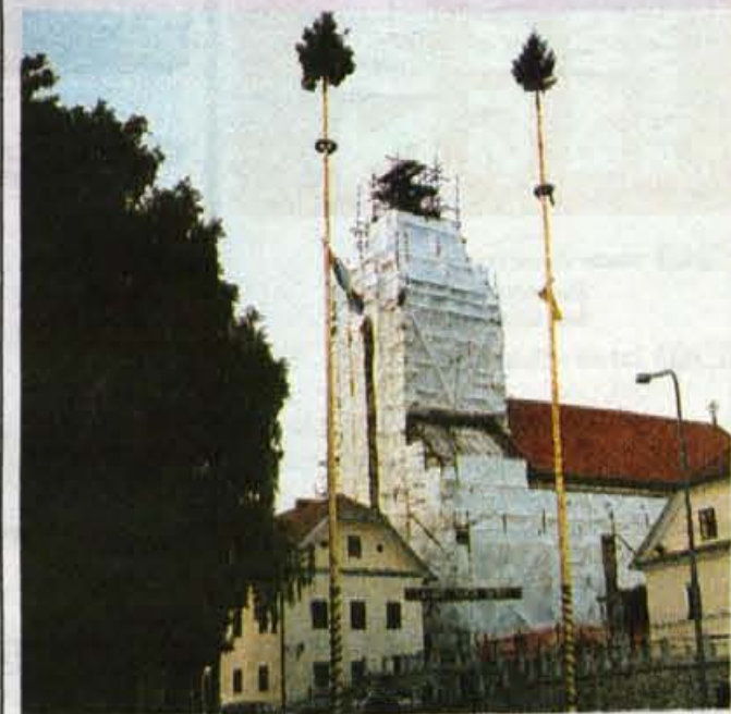
V Komendi prav zdaj potekajo glavna dela na obnovi zvonika in fasade.
