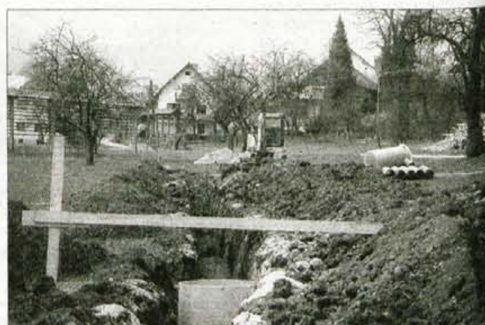
Med gradnjo kanalizacije
