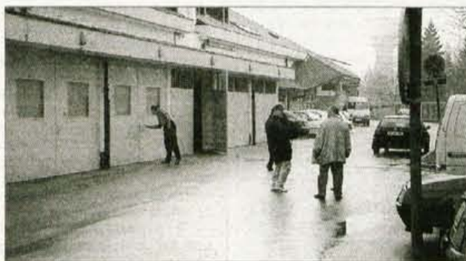
Eksploziralo je pri garažah pošne stavbe.
