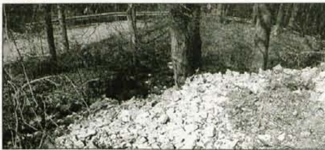
Moteči kup odpadnega gradbenega materiala bodo prekrili z zemljo in obrežje uredili.
