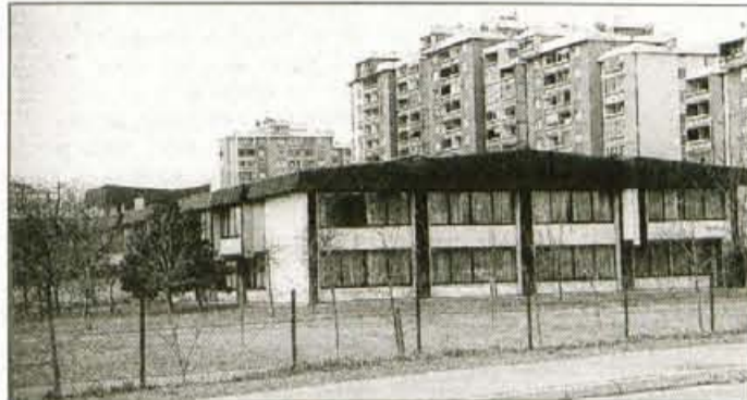
Ob obletnici šole, kjer zadnja leta zaradi manjšega vpisa nimajo prostorskih težav, bo slednja le dobila kakovostno streho, ki ne bo več puščala.
