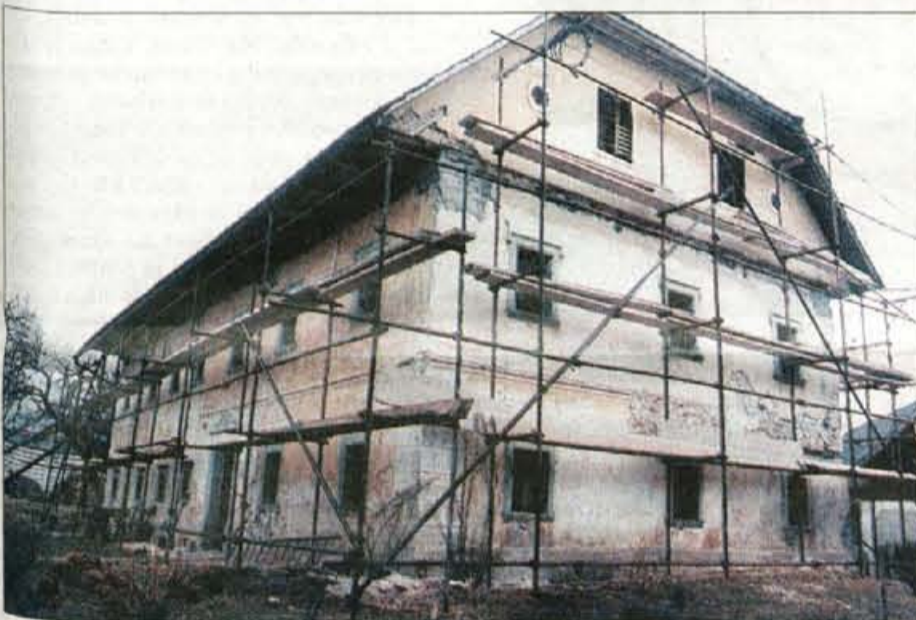
Obnova fasade se je spremenila v popotresno sanacijo.
