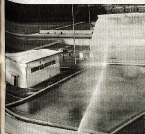
Nov požarni bazen ima kar 1800 kubičnih metrov prostornine in omogoča dve uri neprekinjenega gašenja.
