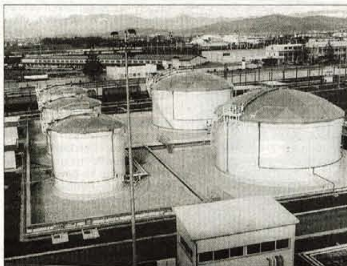
Največji nadzemni rezervoar ima prostornino 10 tisoč kubičnih metrov. Vsi nadzemni rezervoarji so obdani z lovilnimi bazeni, ki v primeru razlitja zadržijo razlito gorivo. Izhlapevanje preprečujejo posebne plavajoče membrane in kupolaste strehe, imajo pa tudi dvojno dno s kontrolo morebitnega puščanja.
