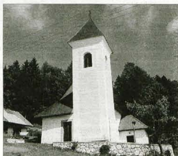
Letos dokončno obnovljena cerkev sv. Ambroža, zaščitnika čebelarjev.
