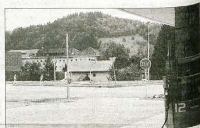
Postavitev novih robnikov in nosilcev za semafor je izhod iz bencinske črpalke na sredo križišča močno zožila. Zlasti nevarna je oskrba z bencini, zato cisterne po posebnem dogovoru goriva pripeljejo zelo zgodaj jutraj, ko promet se to dopušča.
