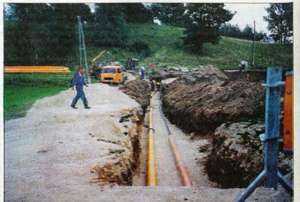
Ob vodovodu tudi plinovod
