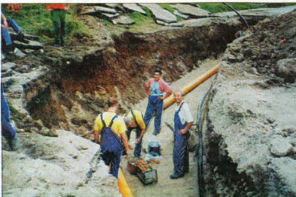
Zamenjava vodovoda in priprava za gradnjo plinovoda.
