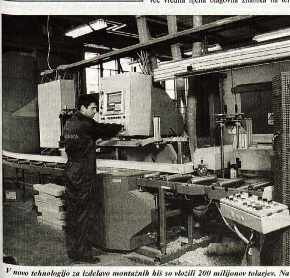
V novo tehnologijo za izdelavo montažnih hiš so vložili 200 milijonov tolarjev. Na sliki računalniško krmiljen razrez sestavnih delov za montažne stene.
