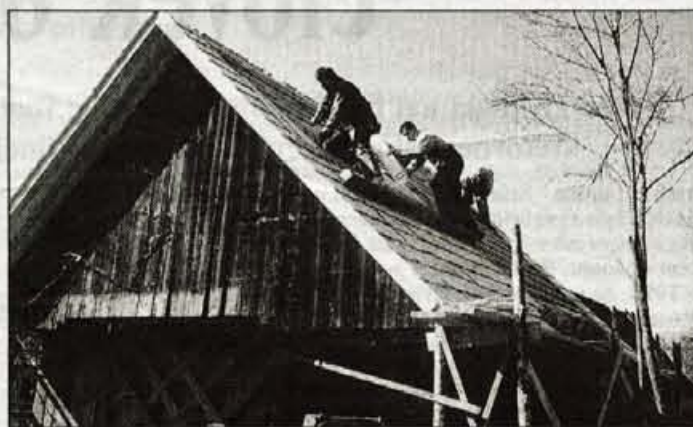
Najprej so se tesarji lotili prekrivanja gospodarskega dela Vogvarjeve hiše.
