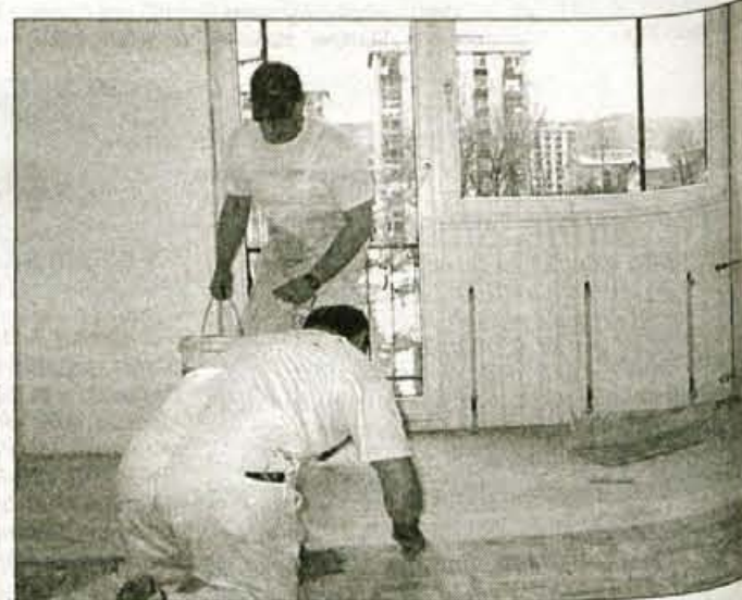
Mojstri Stene med obnovo stanovanja v tretjem nadstropju.
