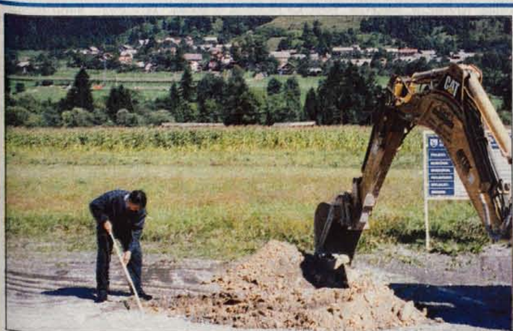
Začetek graditve kanalizacijskega omrežja v Kranjski Gori
