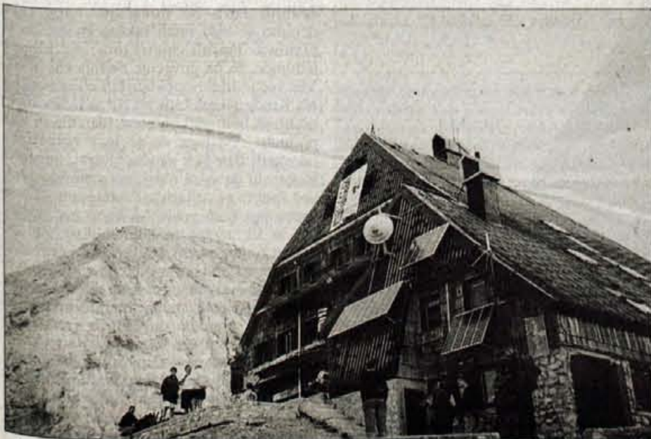
...in skupaj s številnimi sončnimi kolektorji pokrila vse energetske potrebe koč na Kredarici.
