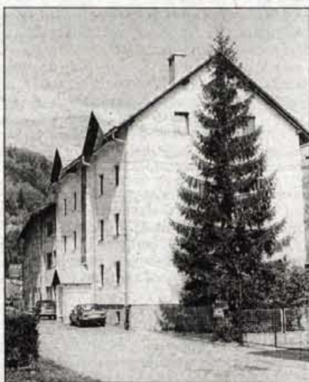
Obnovili stanovanjski blok v Podmežakli
