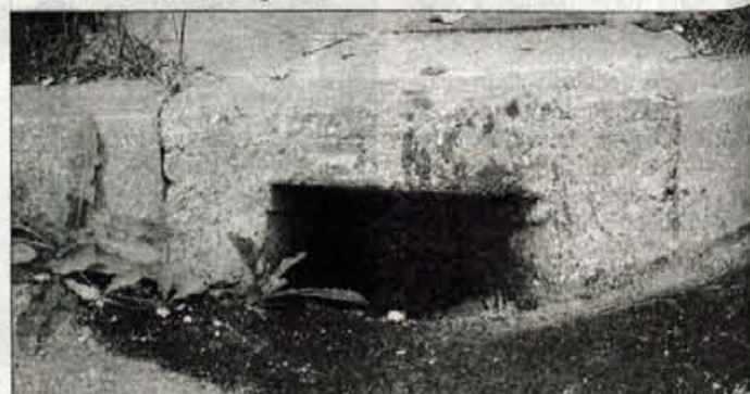
Nova velikost odtočnega kanala.
