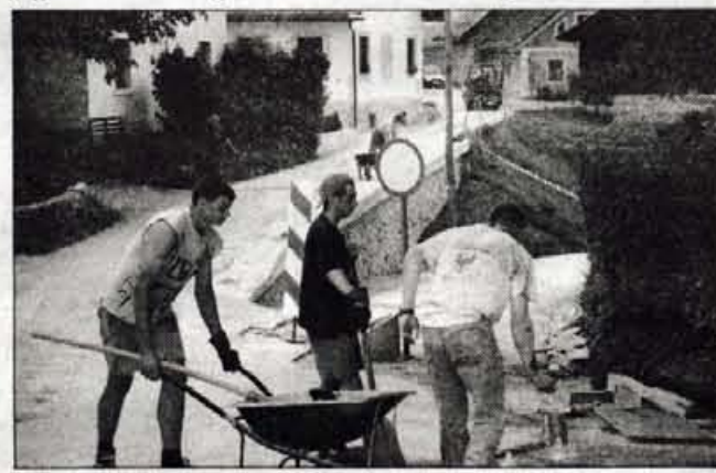
Graditev kanalizacije v Ljubnem
