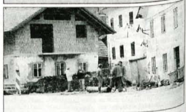
Graditev kanalizacije v Železnikih
