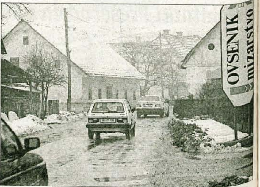
Jezerska cesta čaka na obnovo.
