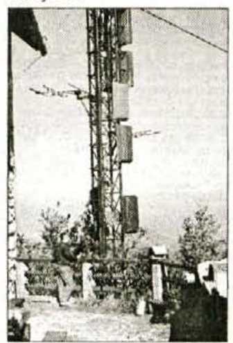
Zadnja dela na oddajniku
