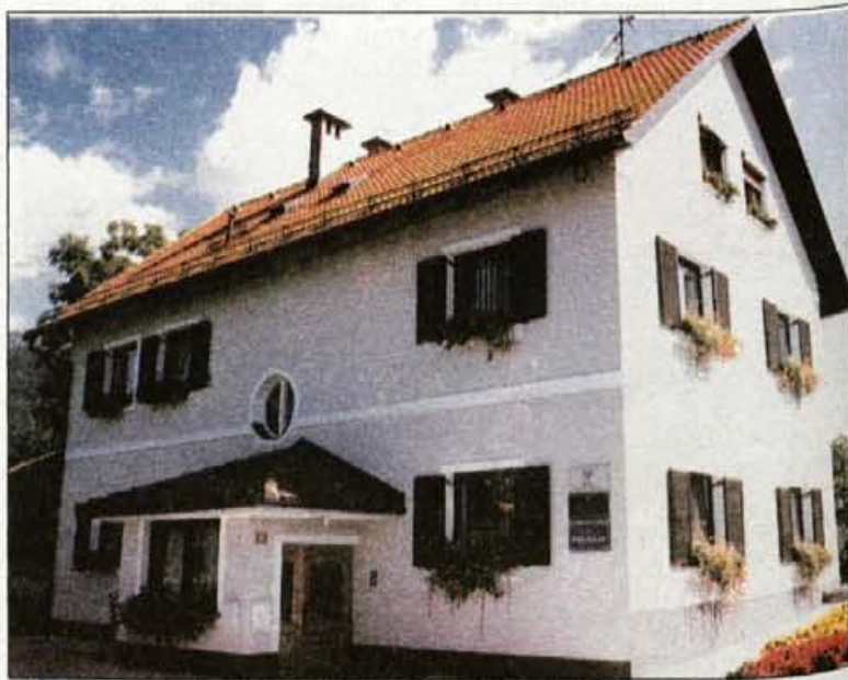
Obnovljena je tudi občinska stavba, kjer sta poleg občinske uprave nastanjena tudi krajevni urad in policijska postaja.
