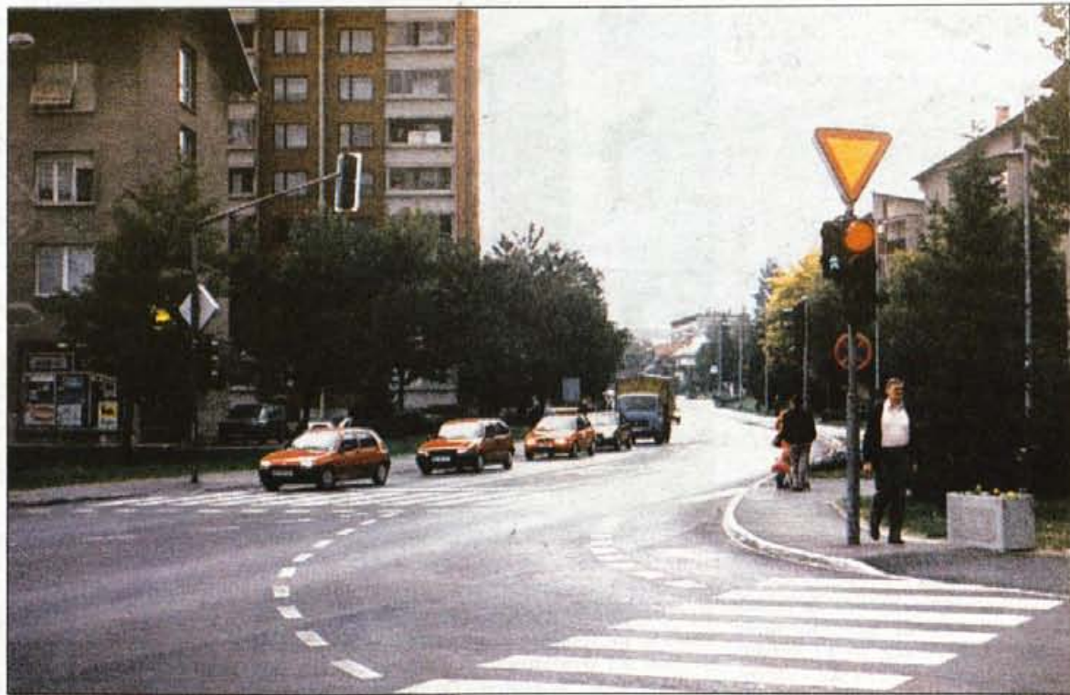
Obnova magistralne ceste skozi Jesenice je za Jesenice v zadnjih dveh letih ena največjih komunalnih pridobitev. Cesta je bila hudo dotrajana, saj je bil spodnji ustroj iz žlindre. Večino denarja je prispevala država, nekaj pa tudi občina.
