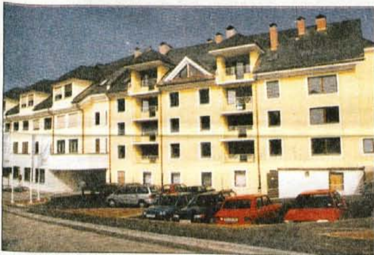
Zavod za zdravstveno zavarovanje na Zlatem polju ter nov stanovanjski blok.
