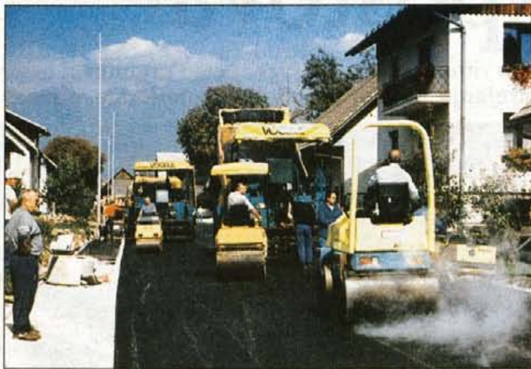
Obnavljanje cest je bila prednostna naloga občine. Tako je tudi z Gasilsko ulico, ki center Šenčurja povezuje z brniško cesto.
