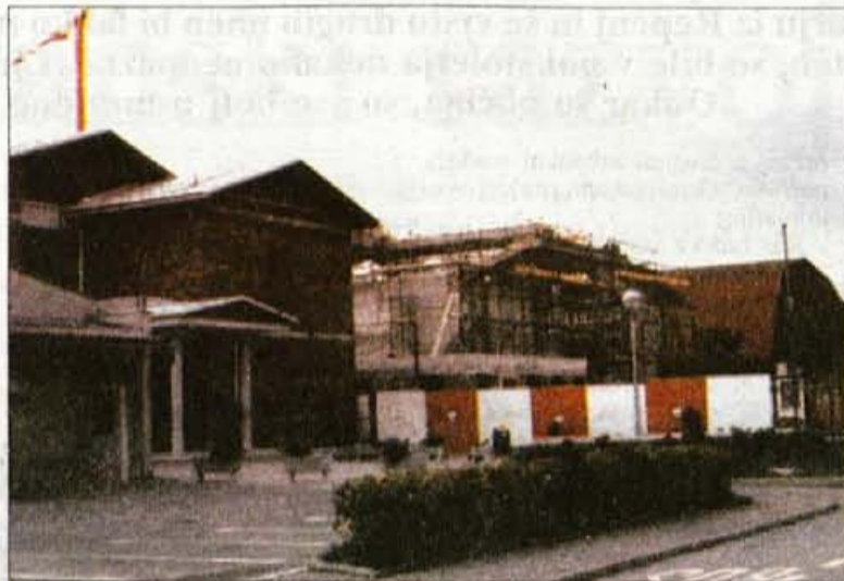
V Komendi ob šoli in vrtcu ter pošti zdaj gradijo še telovadnico.
