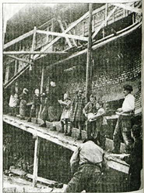
Prostovoljno delo na gradnjah zadrugnih domov.
