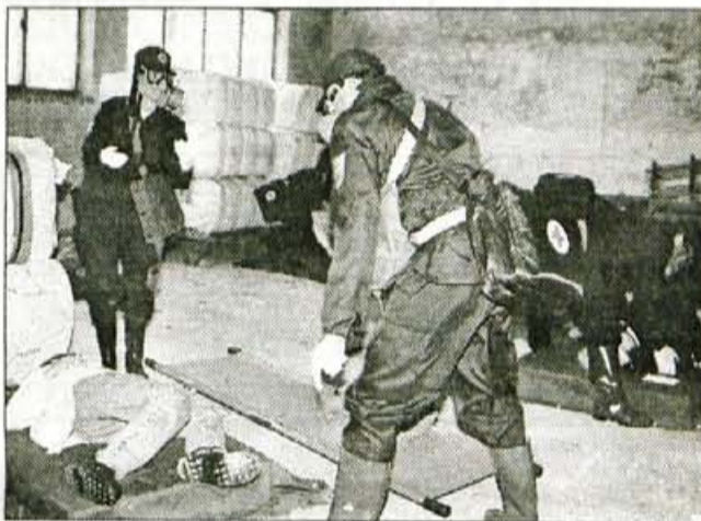
Oceni poškodb je sledilo nudenje prve pomoči ranjencem.
