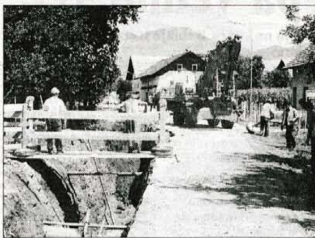
Obnavljajo Gasilsko cesto.
