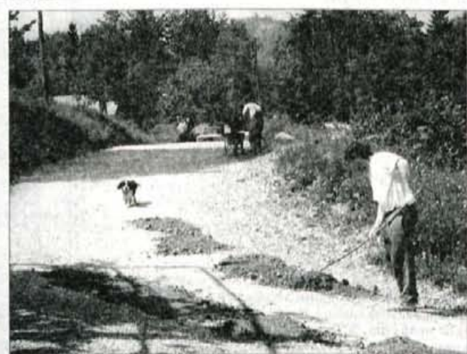
Ta mesec so imeli krajanje na cesti Studenčice - Steška planina, ki so jo sami začeli urejati, že dve delovni akciji. Letošnje poletje so nadpovprečno pogoste obilne padavine, ki so uničile ves trud za ureditev cestnega odseka in pričetek polaganja asfaltne prevleke.
