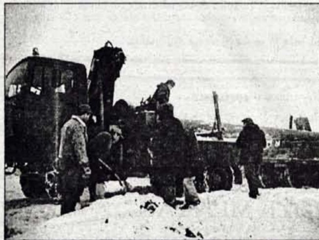
Postavitev nove transformatorske postaje na Kovskem vrhu.
