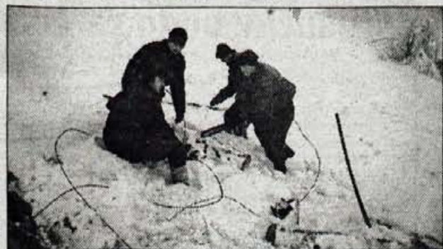
Delavci Elektra pri popravilu daljnovoda - Foto: D. Papler
