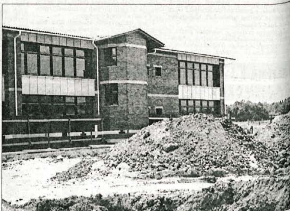
V Komendi so pred kratkim začeli z gradnjo telovadnice.
